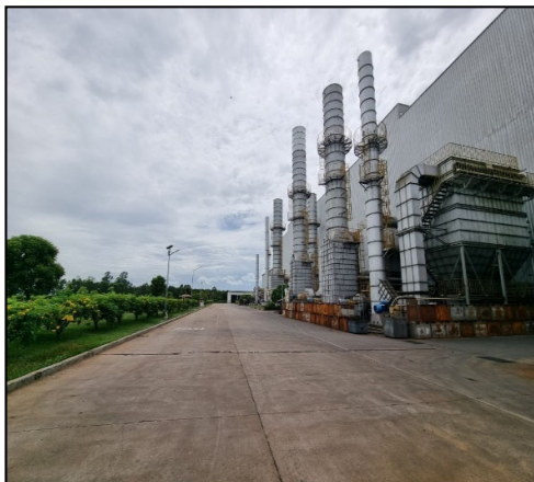
ภาพที่ 2.1 ระบบบำบัดมลพิษทางอากาศ (ระบบดักฝุ่นแบบถุงกรอง Bag Filler)
