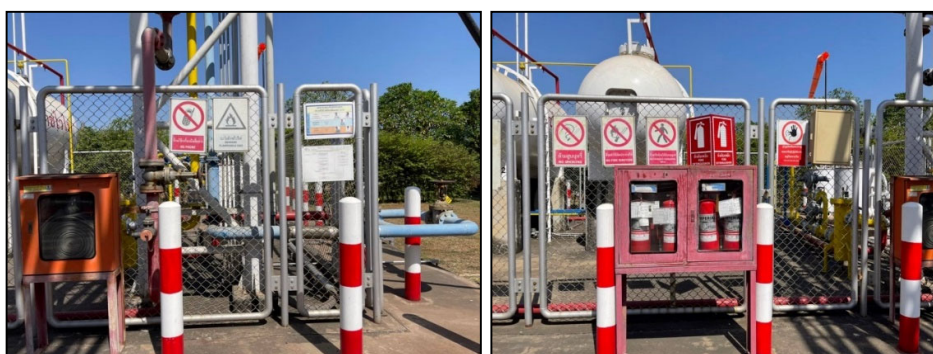
ภาพที่ 2.47 ป้ายเตือนอันตราย วิธีปฏิบัติเพื่อความปลอดภัย ตลอดแนวท่อส่งก๊าซ LPG
