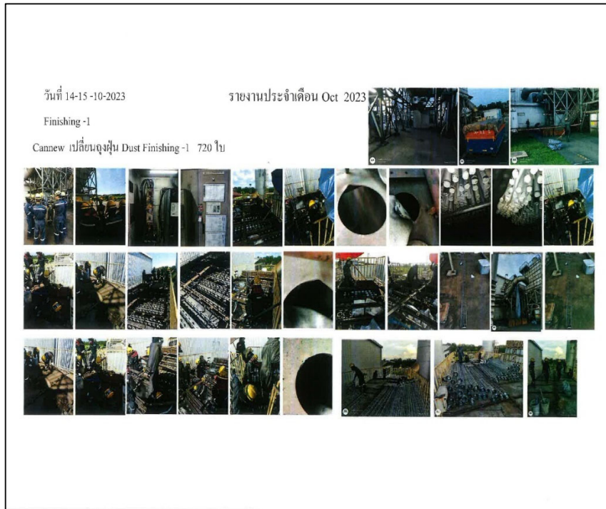
ภาพที่ 2.6 เปลี่ยนถุงกรองของระบบ Bag filter ใหม่ทุก 2 ปี หรือตามสภาพการใช้
