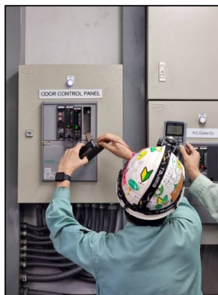
ภาพที่ 2.52 การสอบเทียบและบำรุงรักษาเครื่องวัดกลิ่น
