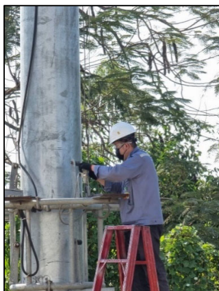
ภาพที่ 2.52 การสอบเทียบและบำรุงรักษาเครื่องวัดกลิ่น
