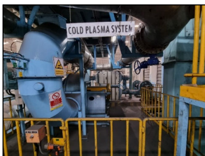
ภาพที่ 2.45 ระบบบำบัดกลิ่นแบบพลาสมาเย็น (Cold Plasma)
